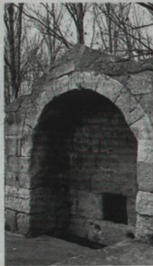
Vista de Muro. M.C.
